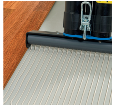
Die Wand- oder Parkettkante dient als Seitenanschlag für den Verteilerkopf.
