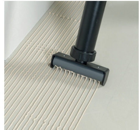
Puppenauftragsgerät X-Bond 200 auf dem Untergrund aufsetzen und der Kleber wird in gleichförmigen Raupen aufgetragen.
