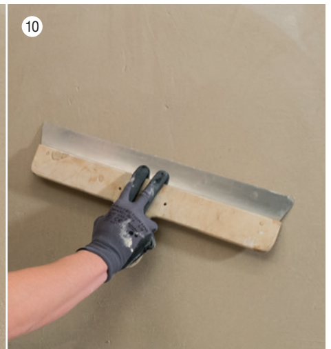
9 Beim Filzen wird die verspachtelte Fläche per feuchtem Filzbrett genässt. Die dadurch entstehende Schlämme an der Oberfläche der Spachtelung lässt sich dann per Flächenspachtel zu einem perfekten Ergebnis gestalten.
