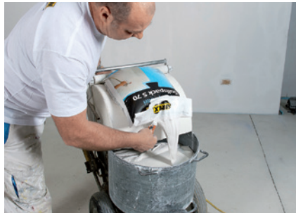
Öffnen der Spachtelmasse mittels Stanley-messer
