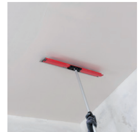
Abziehen mit Parafillspachtel
