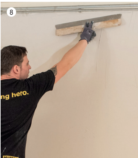
8 ...als auch mit der universell einsetzbaren Filz-Grobspachtel Durapid XL 25 durchführen.
