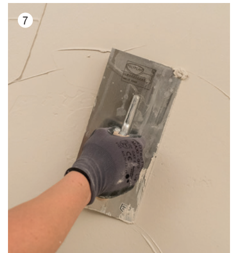
7 Flächenspachtelungen lassen sich sowohl mit der feinen Filz-Feinspachtel Durapid XS 40 ...
