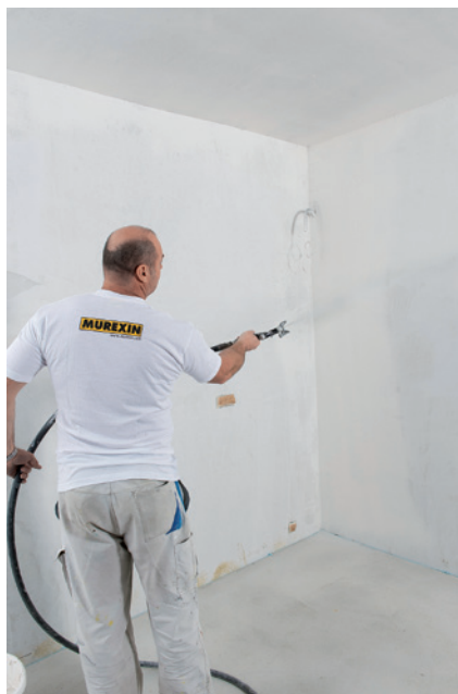
Maschinelles Auftragen der Spritzspachtel Gullspack S 70
