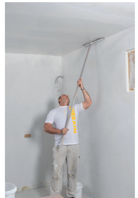
Händisches Glätten der Spachtelmasse
