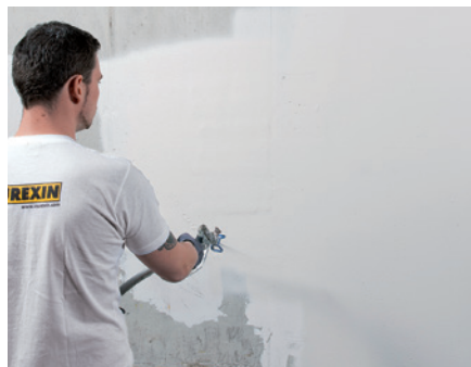
Auftrag in erforderlicher Schichtdicke (bis 5 mm)
