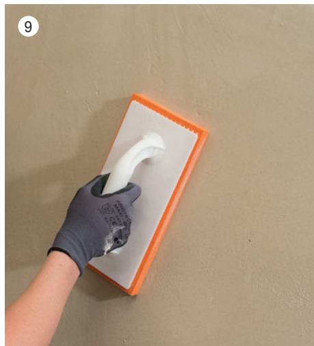
9 Beim Filzen wird die verspachtelte Fläche per feuchtem Filzbrett genässt. Die dadurch entstehende Schlämme an der Oberfläche der Spachtelung lässt sich dann per Flächenspachtel zu einem perfekten Ergebnis gestalten.
