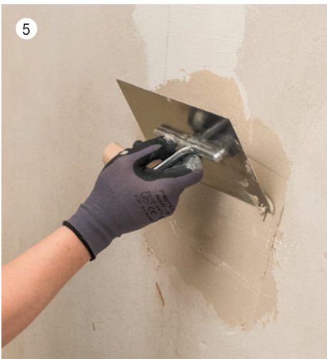
5 Filz-Grobspachtel Durapid XL 25 lässt sich vollkommen eben ausziehen. Nachdem sämtliche Unebenheiten beseitigt sind, kann mit der Flächenspachtelung begonnen werden.
