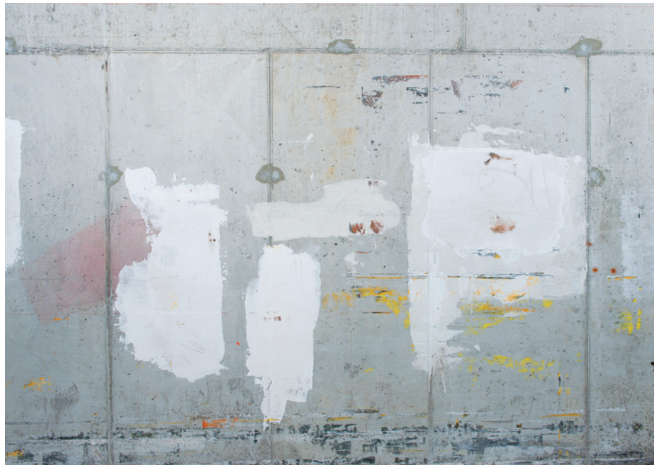
Untergrund: Fertigbeton mit teils 5 mm Fugen und Verunreinigungen
