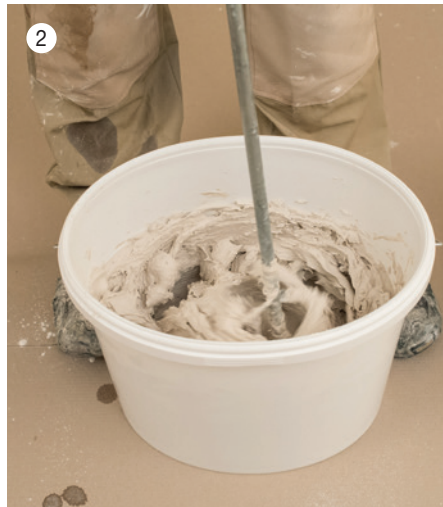
2 Nach kurzer Sumpfzeit maschinell oder händisch aufrühren.
