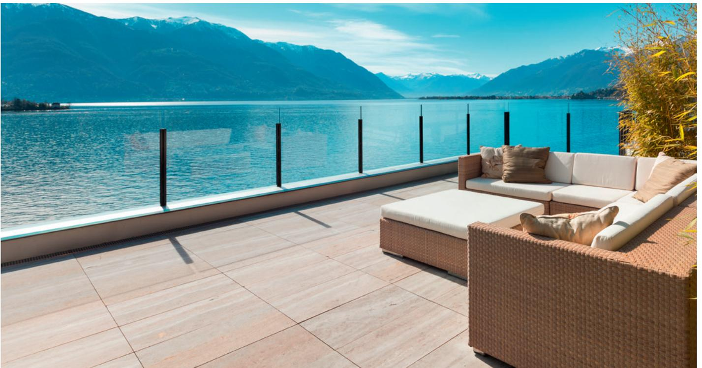
Die Wahlmöglichkeit zwischen zwei Systemen ist in den unterschiedlichen Formaten begründet: Bei größeren Formaten ist eine höhere Oberflächenspannung zu erwarten als bei „kleineren“ Formaten (bis 60 x 60 cm). Der Untergrund muss in jedem Fall die zu erwartende Spannung bruchfrei übernehmen und bedarf daher einer Vorbereitung mit entsprechenden Systemprodukten.
