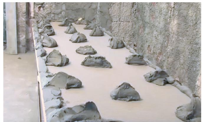
Murexin Klebemörtel punktwise als Mörtelbatzen auf der Platte oder vollflächig am Untergrund aufbringen und die Murexin **Uniplatte** anklopfen.
