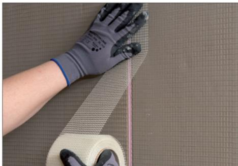
3. Mit Glasseidengewebe **GS 10** schließen sich Plattenstöße.
