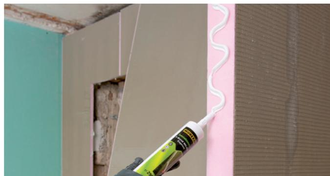
Die Stöße werden mit Murexin **Klebemörtel** oder Spezialklebstoff **X-Bond MS-K88 Express** fixiert.
