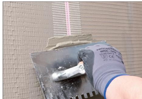
4. Das Glasseidengewebe **GS 10** einlegen, einfach mit Murexin **Klebemörtel** verspachteln – fertig ist der Untergrund!
