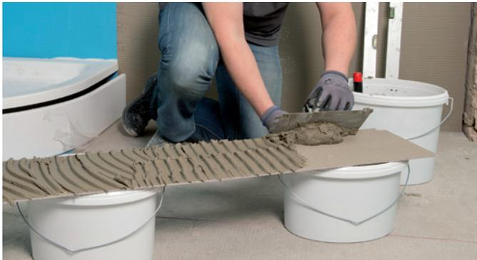
Nach punktuellm oder vollflächigem Aufbringen des Murexin Klebemörtels kann die Murexin **Uniplatte** direkt auf Boden oder Wand geklebt werden.
