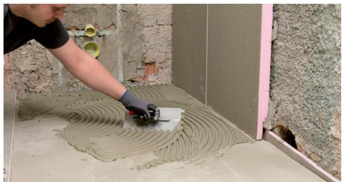
Vollflächige Verklebung mit Murexin Klebemörtel.
