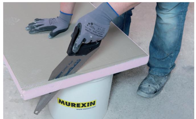
Das Zuschneiden der Murexin **Uniplatte**: Einfach mit dem Fuchsschwanz zurecht sägen ...
