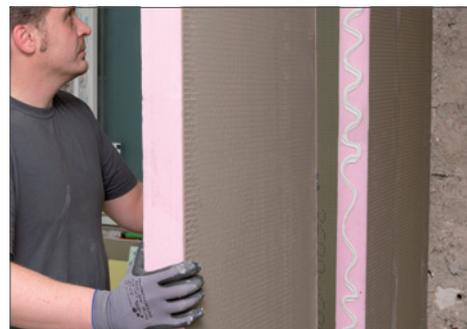
2. Schon kann eine Murexin **Uniplatte** an die andere gefügt werden.
